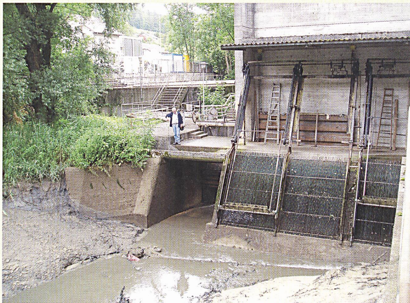
Die Rechen werden erneuert (Bild: ebl).
