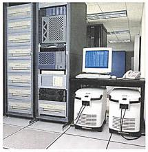
Brennstoffzellenmodule in einem Serverraum (Bild Ballard).
