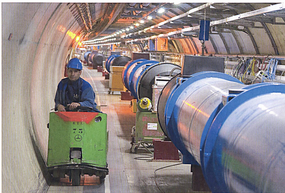
Installation der Magnete für den LHC-Beschleuniger (Large Hadron Collider) im 27-km-Tunnel im CERN (Bild CERN).
