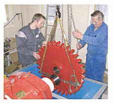
Einbau des Peltonrads im Trinkwasserkraftwerk Sachseln
