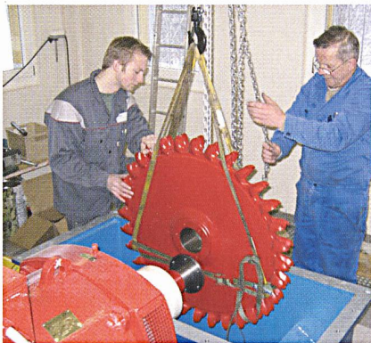
Einbau des Peltonrads im Trinkwasserkraftwerk Sachseln
