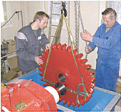
Einbau des Peltonrads im Trinkwasserkraftwerk Sachseln
