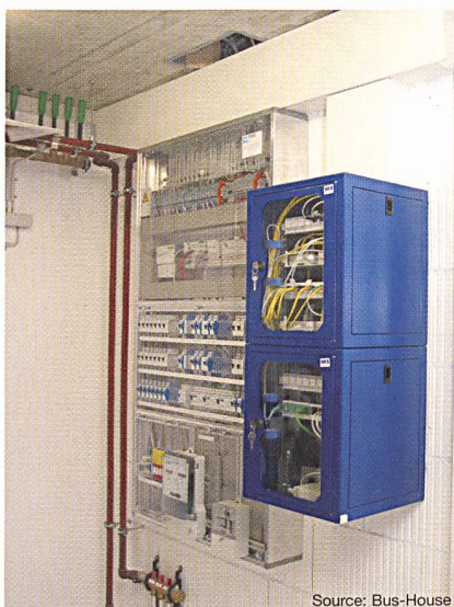
Figure 3 Wago System 750 avec bornes d'entrée/de sortie et connecteur Ethernet dans le système de distribution électrique (à gauche), coffret 9.5" comme centrale de communication (à droite)
