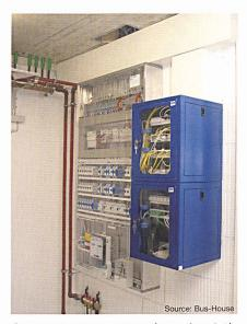
Figure 3 Wago System 750 avec bornes d'entrée/de sortie et connecteur Ethernet dans le système de distribution électrique (à gauche), coffret 9.5" comme centrale de communication (à droite)
