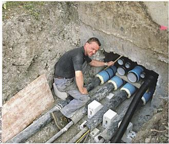
Bild 5 Sanierungen von Kabeleinführungen bringen oft Überraschungen und sind aufwändiger als Neubauten
