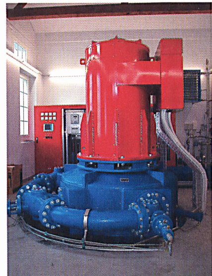
Anstelle einer Reparatur der 75-jährigen Maschinengruppe wurde eine neue installiert.
