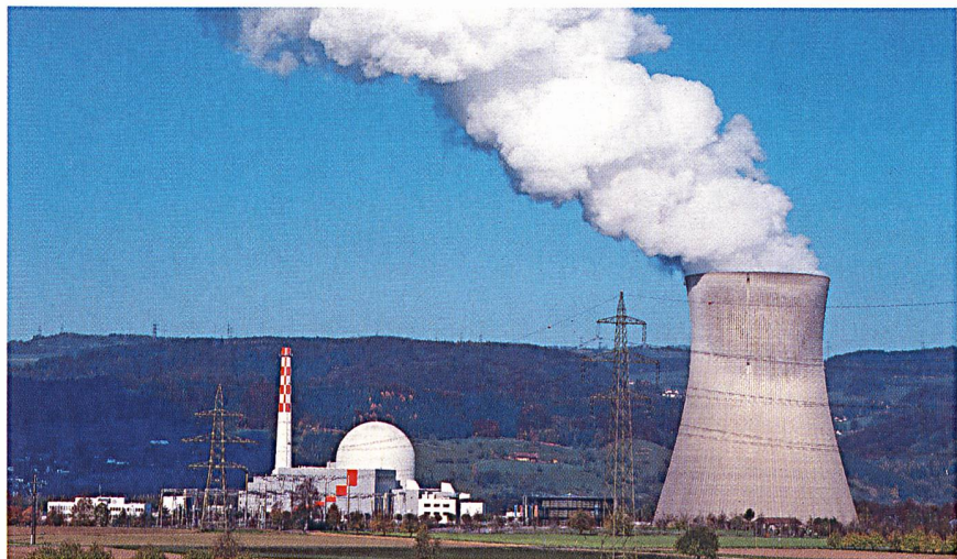
Kernkraftwerk Leibstadt (Bild: kkl).
