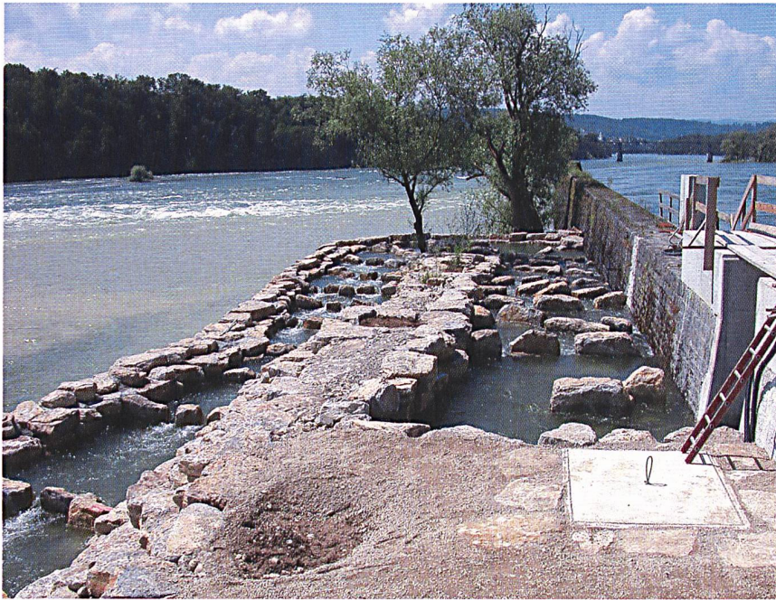
Ein natürlicher «Durchgang» für die Rheinfische (Bilder: energiedienst).
