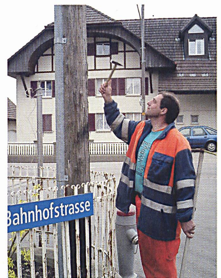
Kontrolle der Holzleitungsmasten.
