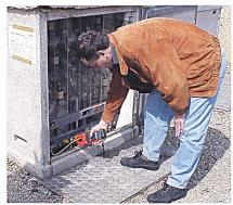
Erdungsmessung in Verteilkasten.
