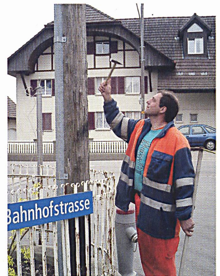
Kontrolle der Holzleitungsmasten.
