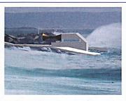
Das Prinzip: Ein Trichter fängt die Wellen auf. Diese komprimieren Luft in einer Kammer, die dann wiederum die Turbinen und Generatoren antreibt.
