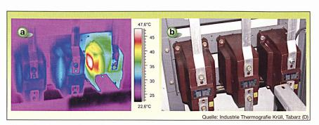
Bild 1 Infrarotkameras erkennen heisse Leitungen und Kontakte (a), die das Auge übersieht (b)
