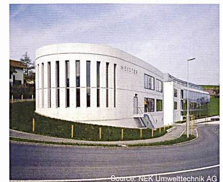
Figure 7 Usine et bureaux à Wollerau, Schwyz, chauffés et refroidis par un champ de 32 sondes géothermiques
