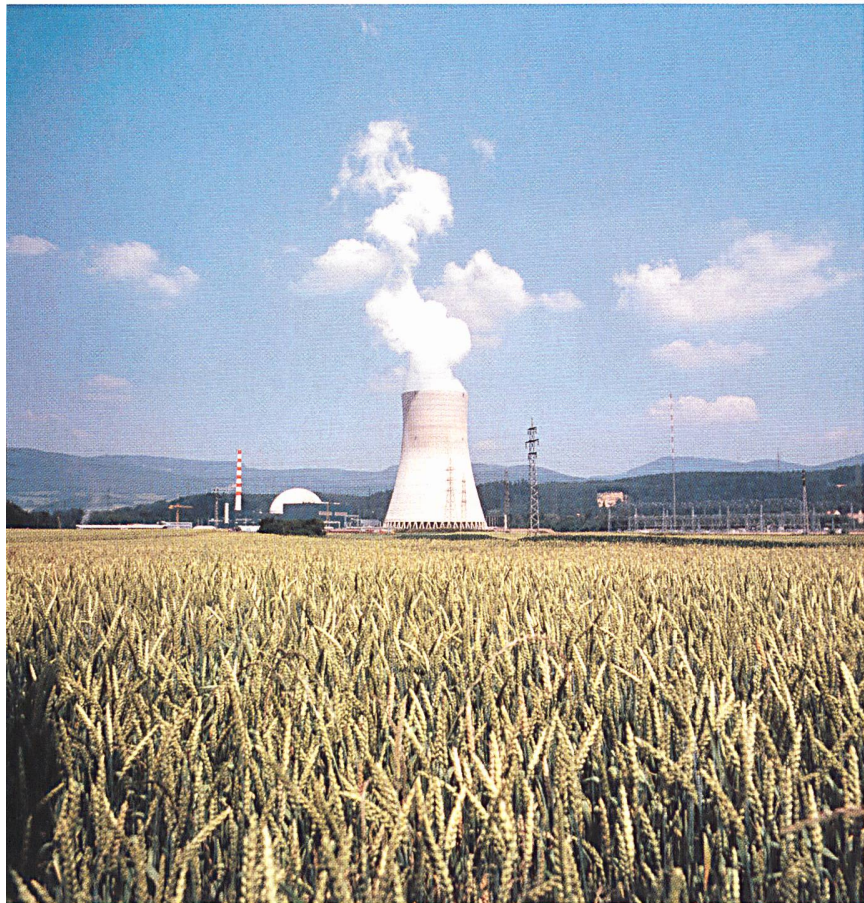
Wesentliche Entscheide für den weiteren Betrieb der bestehenden Kernkraftwerke (Kernkraftwerk Gösgen).
