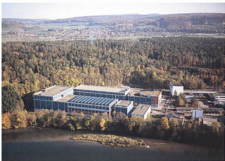
Das neue Kernenergiegesetz bringt Rahmenbedingungen für Entsorgungsanlagen (Zentrales Zwischenlager Würenlingen).
