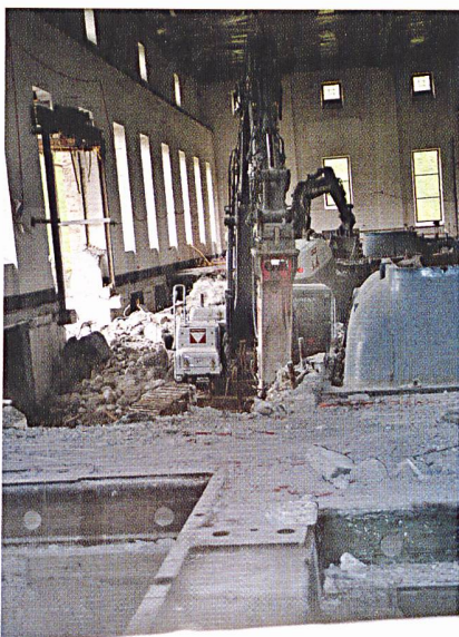
Abbruch im Maschinensaal: Künftig produzieren nur noch zwei Drehstromgruppen je 22 MW Elektrizität.
