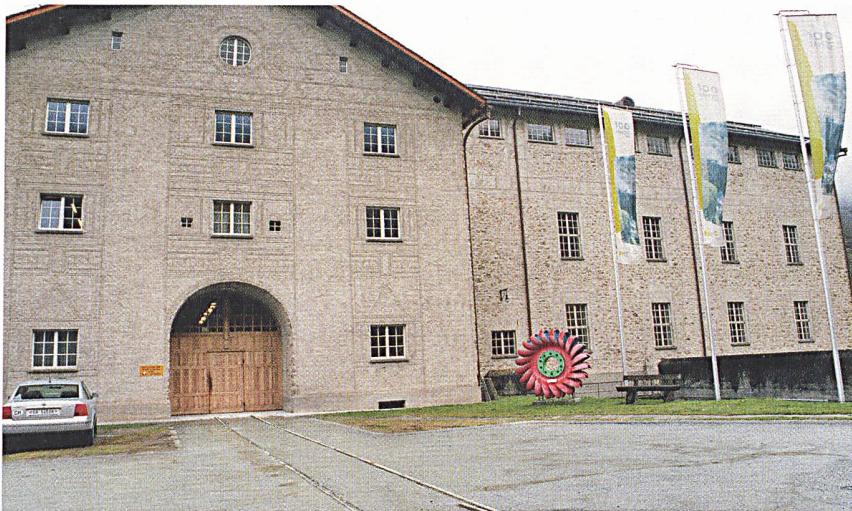
Der grosse historische Technikbau der Zentrale Küblis soll erhalten bleiben (Bilder: wü).
