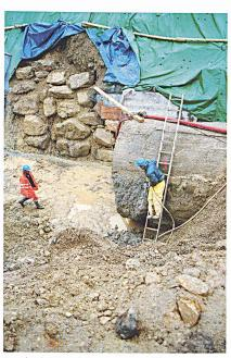
Das durch Schwefelwasser angegriffene Betonrohr im Bereich Klosters/Schlappin muss ersetzt werden.
