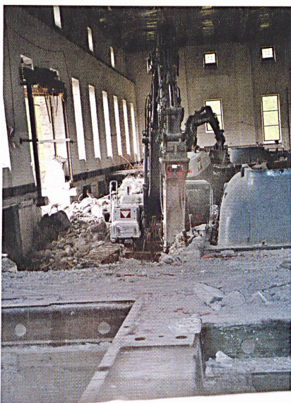
Abbruch im Maschinensaal: Künftig produzieren nur noch zwei Drehstromgruppen je 22 MW Elektrizität.
