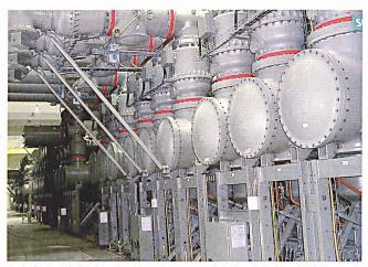
Gasisolierte Schaltanlage in einem Umspannwerk in Saudi Arabien (Bild Siemens).
