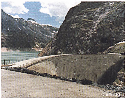
Staumauer des Limmernsees, der zu den Linth-Limmern-Werken im Glarnerland gehört
