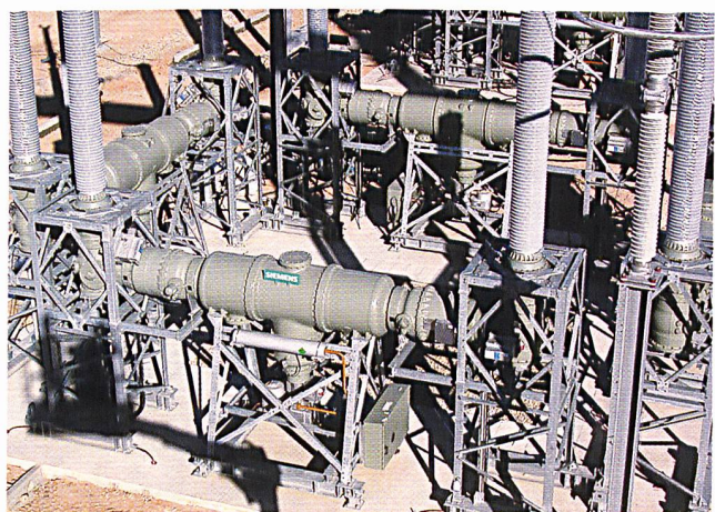
420-kV-Hochspannungs-Schaltanlage.
