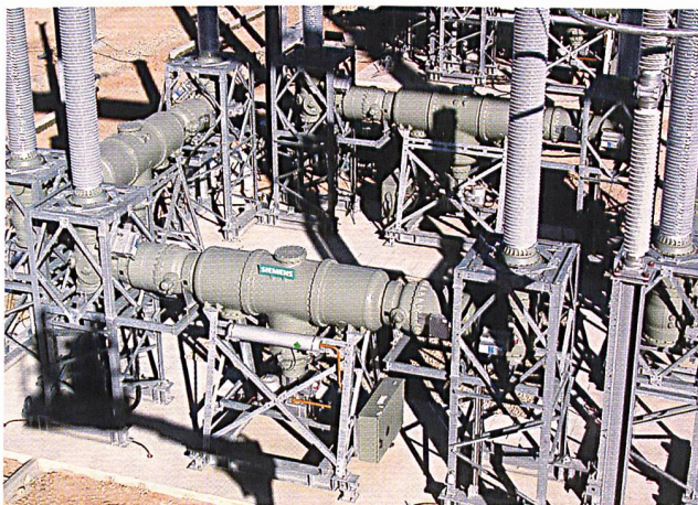
420-kV-Hochspannungs-Schaltanlage.
