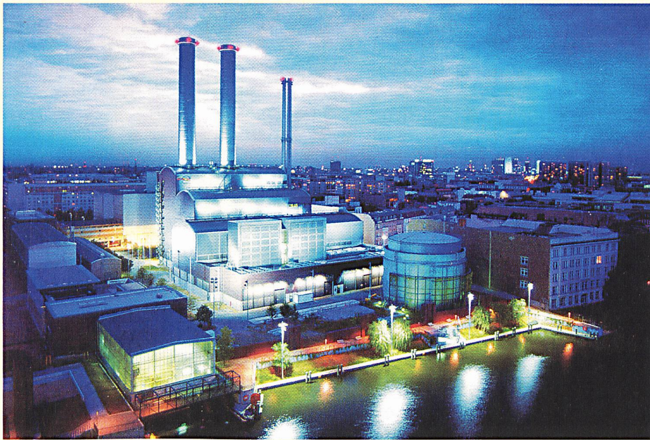
«Heizkraftwerk Mitte» im Zentrum von Berlin (Bild Vattenfall).
