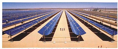
Schon heute produzieren die solarthermischen Kraftwerke in der kalifornischen Mojawe-Wüste den günstigsten Solarstrom weltweit. Das Bild zeigt Parabolrinnenkollektoren, die Hochtemperaturwärme von 390 Grad Celsius erzeugen. Damit wird ein konventionelles Dampfkraftwerk betrieben (Bild: SEGS).
