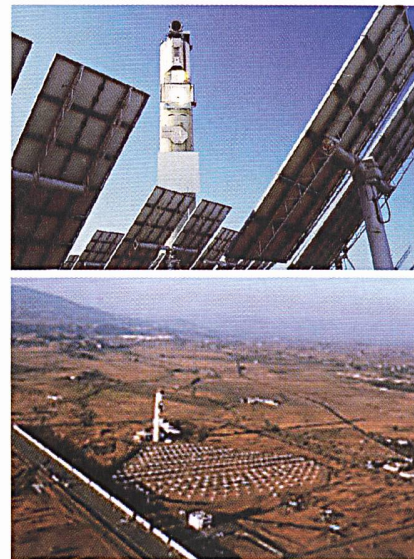
Spanische Testanlage Plataforma Solar in Almería. Im unteren Bild vorne links: 500-m-Teststrang eines Parabolrinnenkollektors zur direkten Dampferzeugung, daneben CESA I Turm mit Heliostatfeld (Foto: Forschungsverbund Sonnenenergie; PSA/DLR).
