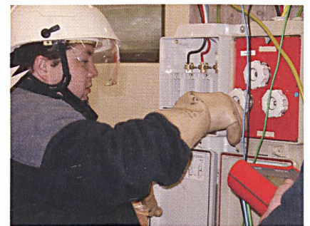
Links: Alles wird genauso einstudiert: Schulung der Abteilung Netzbau Elektrizität. – Rechts: Unter strengen Vorschriften: Arbeiten am Hausanschlusskasten
