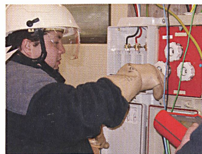
Links: Alles wird genauestens einstudiert: Schulung der Abteilung Netzbau Elektrizität. – Rechts: Unter strengen Vorschriften: Arbeiten am Hausanschlusskasten
