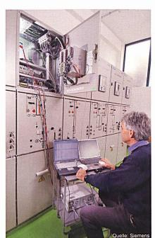
Bild 1 Unterwerk Winznau Schachen nach IEC 61850
