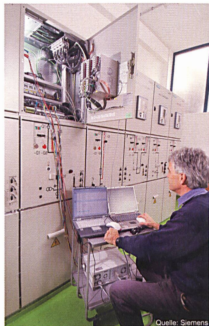
Bild 1 Unterwerk Winznau Schachen nach IEC 61850
