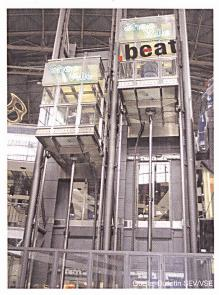
Bild 11 Hydraulikaufzug
