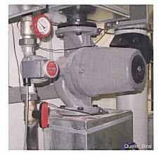
Bild 10 Pumpenaustausch durch richtig ausgelegte Magnetmotorpumpe
