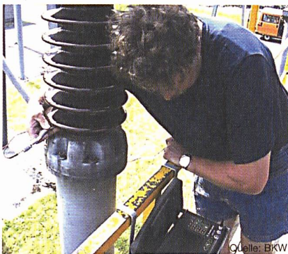
Bild 1 Ultraschallmessung Kontrolle von Porzellanisolatoren auf Risse mittels US-Messung
