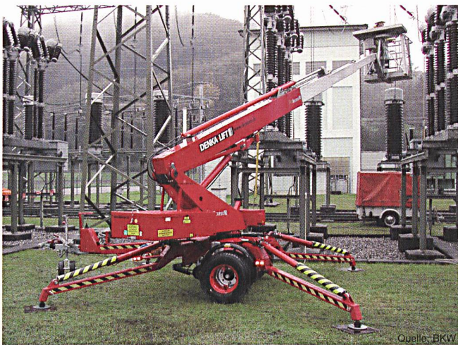
Bild 3 Sicheres Arbeiten Einsatz eines selbst fahrenden Gelenksteigers zur Ausführung der Wartungsarbeiten
