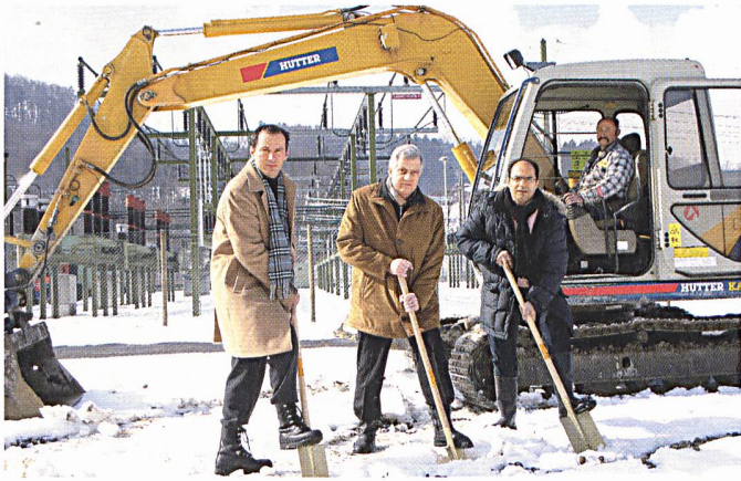
Spatenstich auf dem Baugelände in Sulgen. V.l.n.r.: Urban Kronenberg, Direktor EKT; Edwin Wirth, Leiter Anlagenbau; Maurizio Balletta, Planung/Bauleitung Hochbau.
