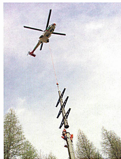
Aufstellen eines Strommastes mit Helikoptereinsatz (Bilder: sak).
