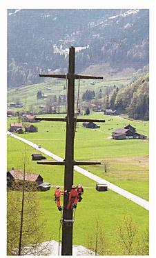
Die Mastspitze der Freileitung wird mit dem unteren Teil verbunden.
