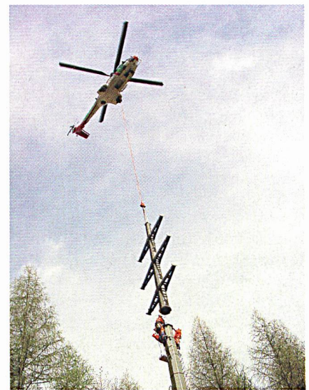
Aufstellen eines Strommastes mit Helikoptereinsatz (Bilder: sak).
