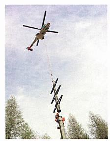
Aufstellen eines Strommastes mit Helikoptereinsatz (Bilder: sak).
