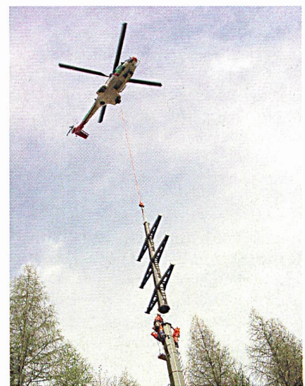
Aufstellen eines Strommastes mit Helikoptereinsatz (Bilder: sak).
