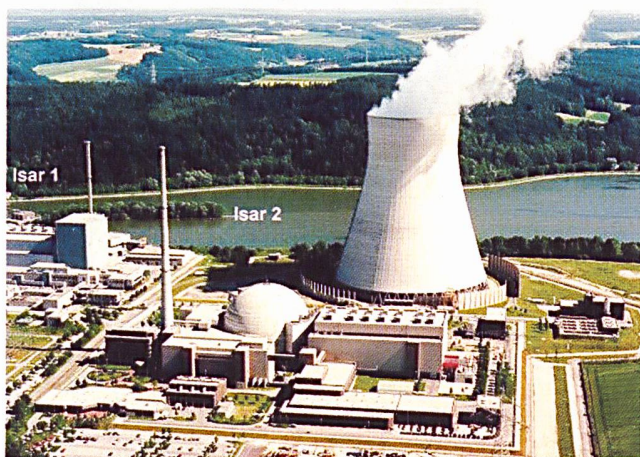
Produktionsstärkste deutsche Anlage war das Kernkraftwerk Isar 2 (Bild Siemens).
