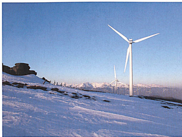
In Österreich sind 424 Windkraftanlagen mit insgesamt 606 MW am Netz (Tauernwindpark Oberzeiring/Bild IG Windkraft).
