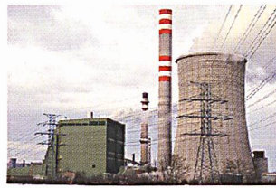
Hochspannungsleitungen beim thermischen Kraftwerk ECKG bei Prag (Bild Atel).
