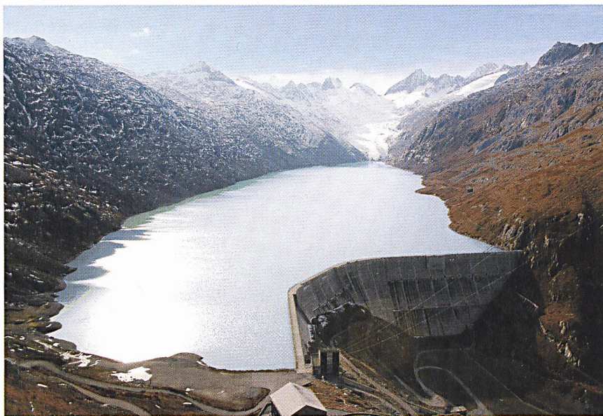
Bild 1 Schlechte Lastprognosen bewirken oft ungeplanten Strommehrverbrauch, der mit schnell reagierenden Speicherkraftwerken ausgeglichen werden muss und teuer ist. Die Staumauer am Oberaarsee dient zusammen mit dem ebenfalls gestauten Grimselsee der Veredelung von Strom, es wird vorwiegend kostbare Regelenergie erzeugt.
