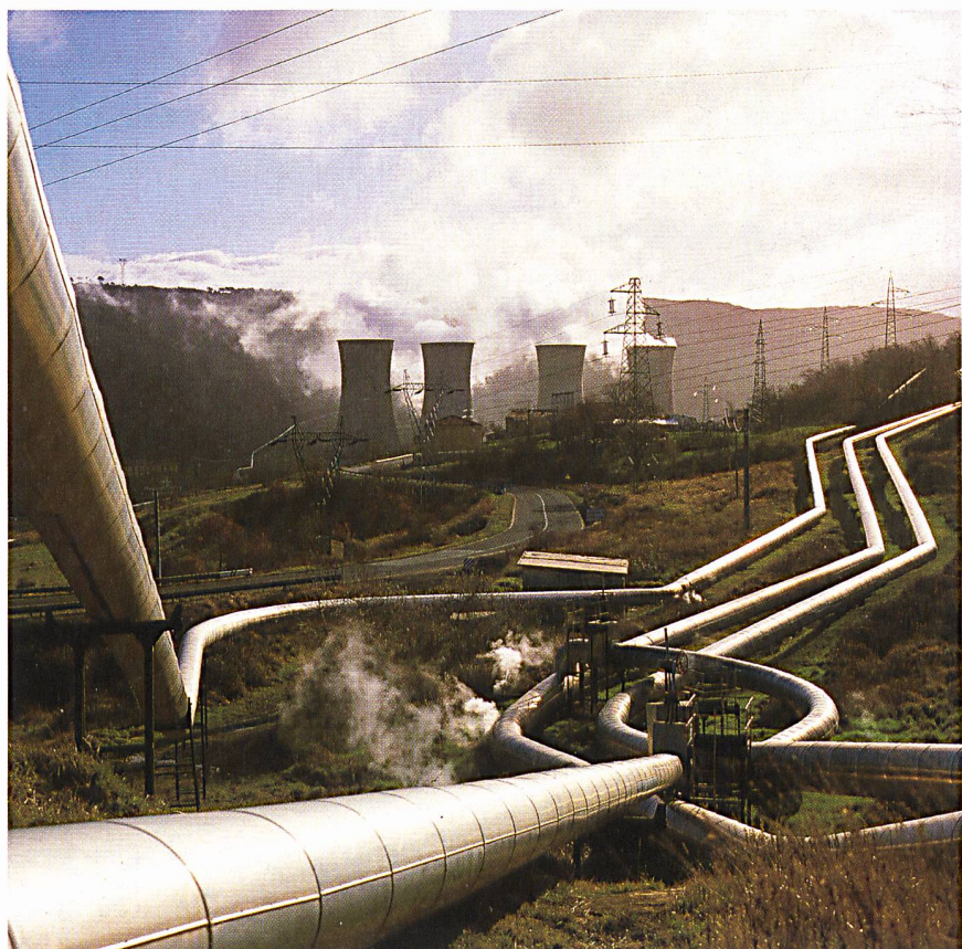
Geothermische Dampfleitungen bei Larderello (Fotos Enel).
