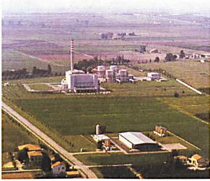
Fernheizwerk Ferrara mit geothermischer Quelle.
