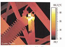
Infrarotbild einer heissen Anschlussklemme. Korrosion führte zum schlechten Kontakt.
