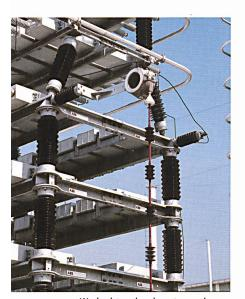
Wechselstromkondensatoren einer Hochspannungs-Gleichstromübertragungsleitung (HGÜ, Bild ABB)
