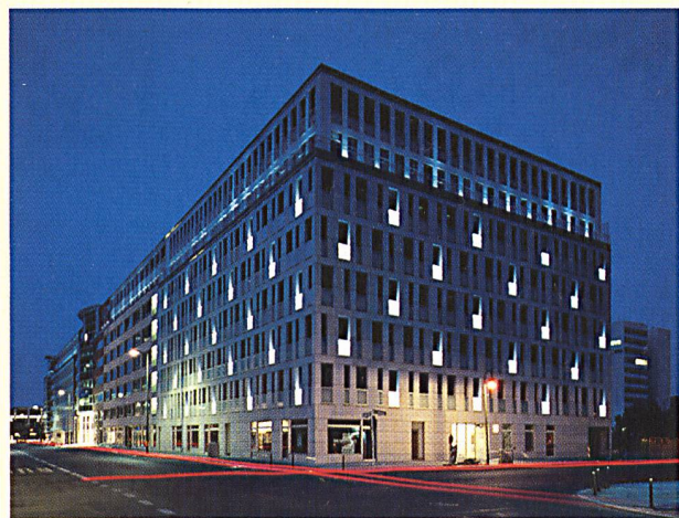
Leuchtdioden: das Aus für die Glühbirne? (im Bild Brüstungselemente durch LED-Sonderleuchten beleuchtet; Foto LEDolutions).
