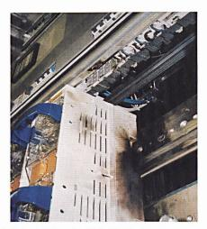
Beim Anheben der NH-Leiste zündete ein stromstarker Lichtbogen. – En soulevant la réglette des éléments BT, un arc électrique de haute intensité a éclaté.
