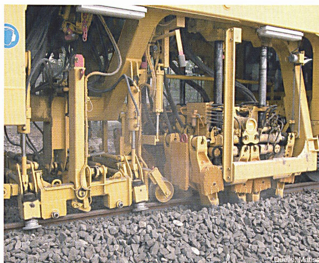
Bild 2 Das Schotterbett wird aufgelockert und die Schiene millimetergenau positioniert
