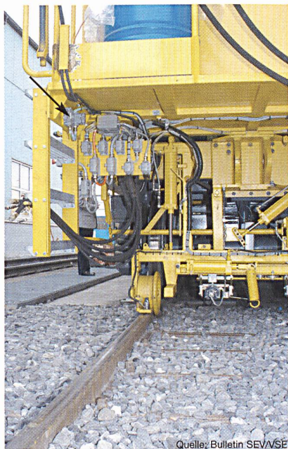
Bild 4 Einige Ethernet-Stecker sind aussen montiert – und unter dem Trittbrett nur gerade gegen den Regen geschützt.
