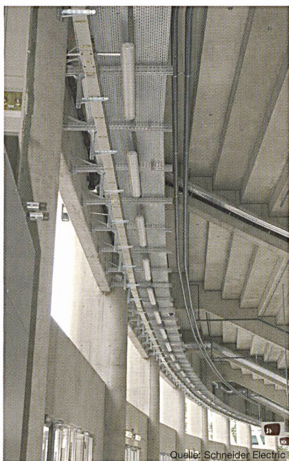
Bild 6 Stromschienen im Radius verlegt: Stadium La Praille in Genf
