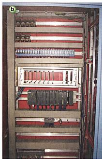
Bild 2 Reglerkarten mit SPS ersetzen
