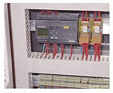
Bild 1 Mikrosteuerungen ersetzen aufwändige Relaisschaltungen
