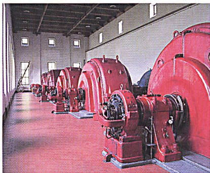
Im Kraftwerk Küblis sind fünf Turbinengruppen in Betrieb. Zwei davon produzieren einphasigen Bahnstrom (Bild: repower).
