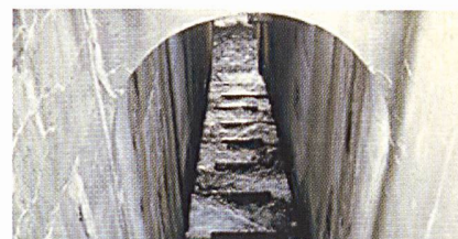
Fischpass im Rheinkraftwerk Eglisau.
