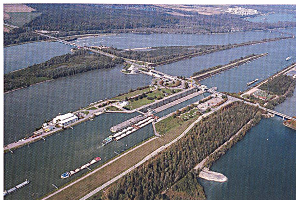
Rheinkraftwerk Iffezheim mit Fischpass.
