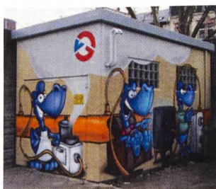
Gestaltet von der Agentur Artmos4: Verteilstation der Gasversorgung Offenbach
