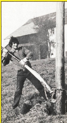
Nachimprägnierung von Holzmasten
