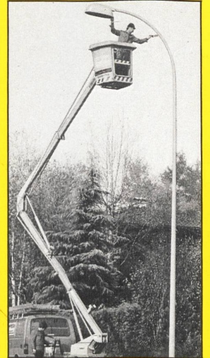
Korrosionsschutz an Stahlkandelabern
