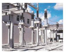
Versorgung Werk Potiguar Natal: Hochspannungsanlage 69 kV und Transformator 5 MVA 69/13.8 kV
