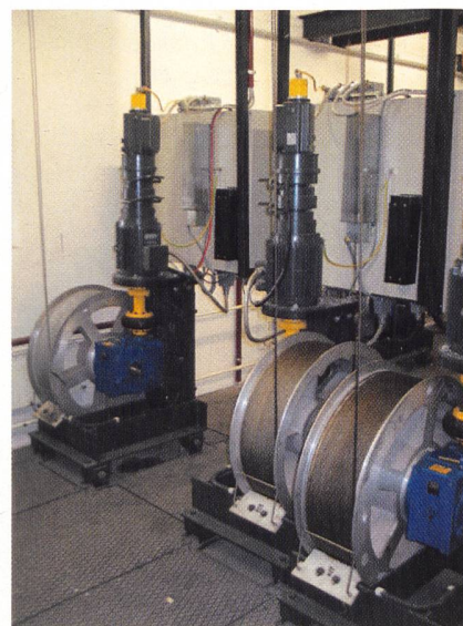
Die 90 Antriebe für die Prospekt- und Punktzüge werden über Computer angesteuert
