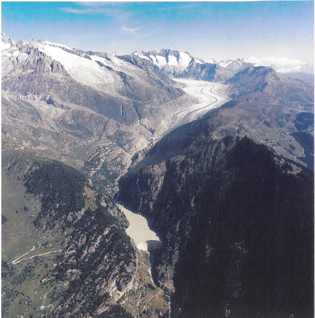
Probleme mit der Alpenkonvention (122 m hohe Stauanlage Gebidem/Bitsch (VS) mit Aletschgletscher).
