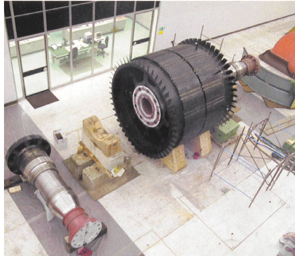
Ersatz von Generatoren im Wasserkraftwerk Biasca (TI).
