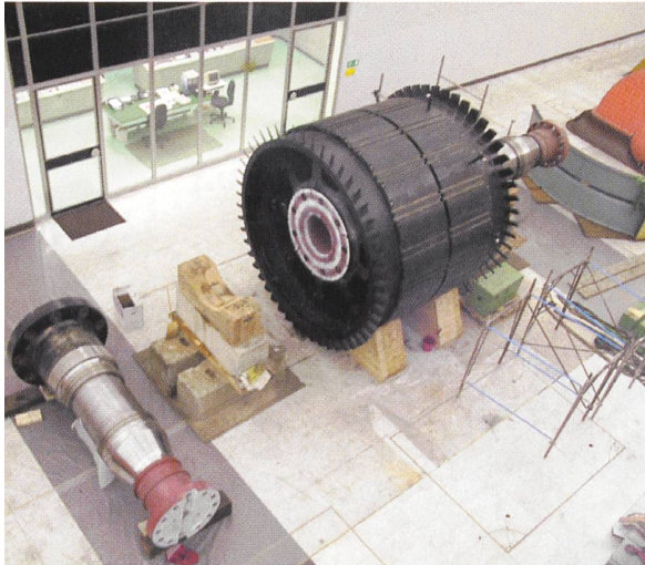
Ersatz von Generatoren im Wasserkraftwerk Biasca (TI).
