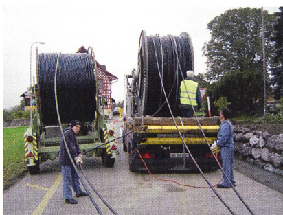
Verlegen der neuen Kabelleitungen.
