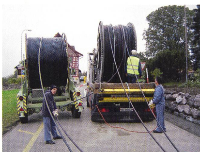
Verlegen der neuen Kabelleitungen.
