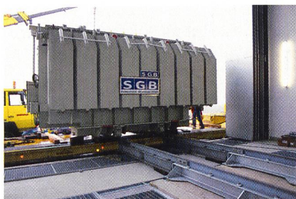
Vom Tieflader ins Unterwerk.
