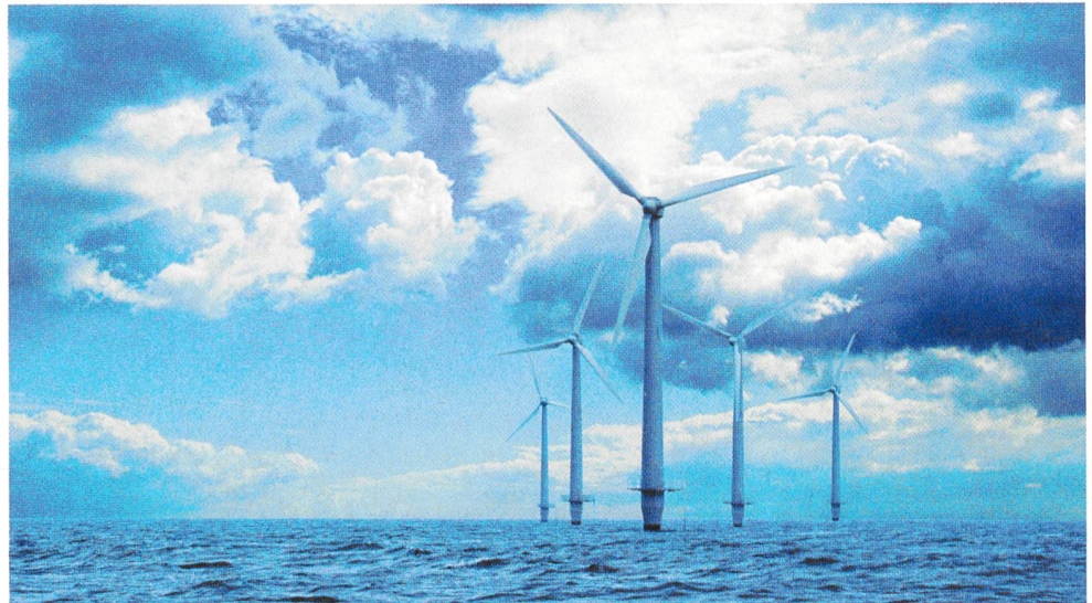
Windpark in der Ostsee (Foto NEG Micon).
