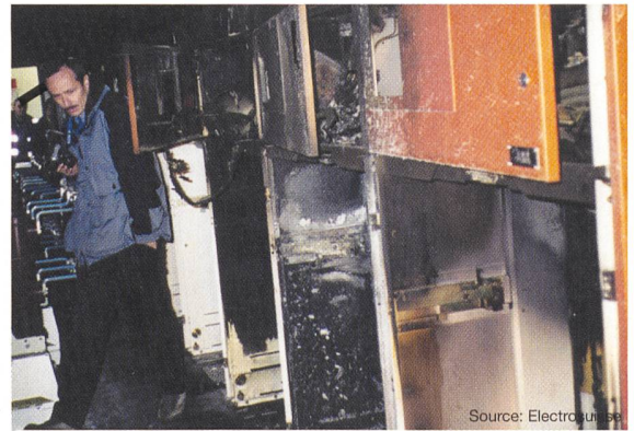
Figure 10 Vue de l'installation de couplage détruite
