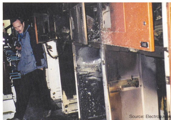
Figure 10 Vue de l'installation de couplage détruite
