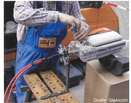
Bild 3 Spleissen der Kabel
