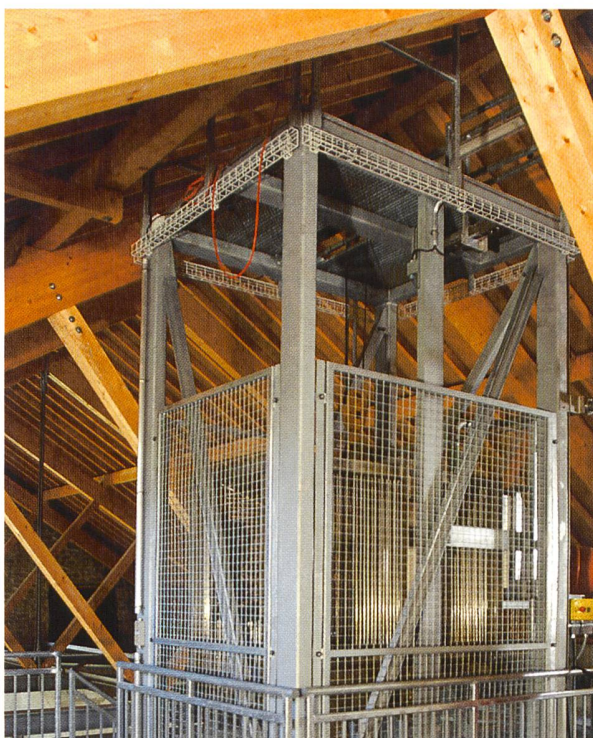
Fischlift und Aufzugswanne im Kraftwerk Magere Au. Damit können die Fische auch einen Staudamm überwinden (Bilder: few).
