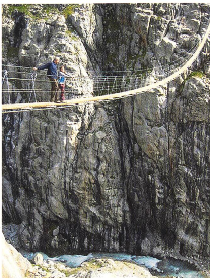
Dank der neuen Hängebrücke erreichen die Bergsteiger bequem die Trifthütte (Bild: kwo).
