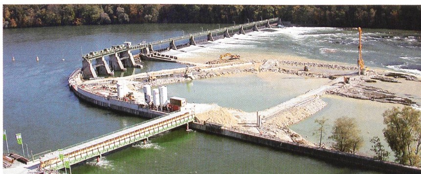
Die Erzeugung von Strom aus Wasserkraft, Biomasse, Erdwärme, Sonnen- und Windenergie oder Erdwärme hat unbestreitbare Vorzüge, erfordert jedoch grosse Investitionen (im Bild z.B. Baustelle Kraftwerk Rheinfelden/Foto Naturenergie).
