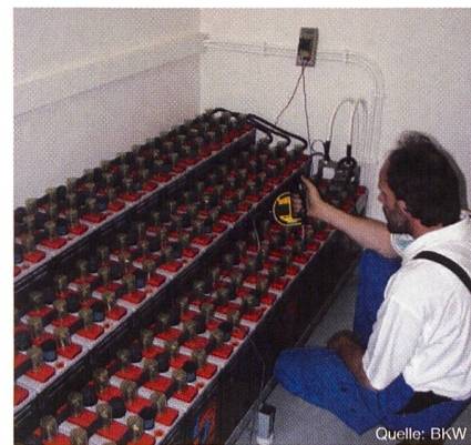
Bild 1 Messung der Säuredichte
