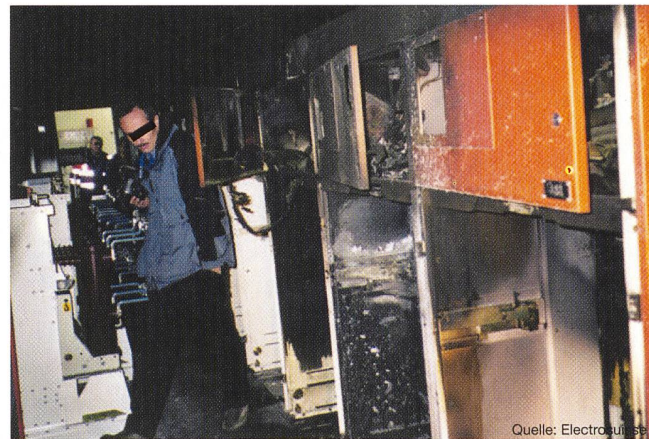
Bild 10 Ansicht der zerstörten Schaltanlage
