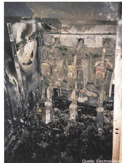
Bild 11 Durch den Kurzschluss vollständig zerstörte MS-Schalterzelle
