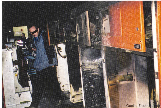
Bild 10 Ansicht der zerstörten Schaltanlage
