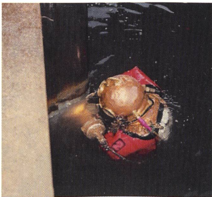
Leco-Beschichtung von Lestin & Co, Wien, wird von einem Taucher aufgebracht
