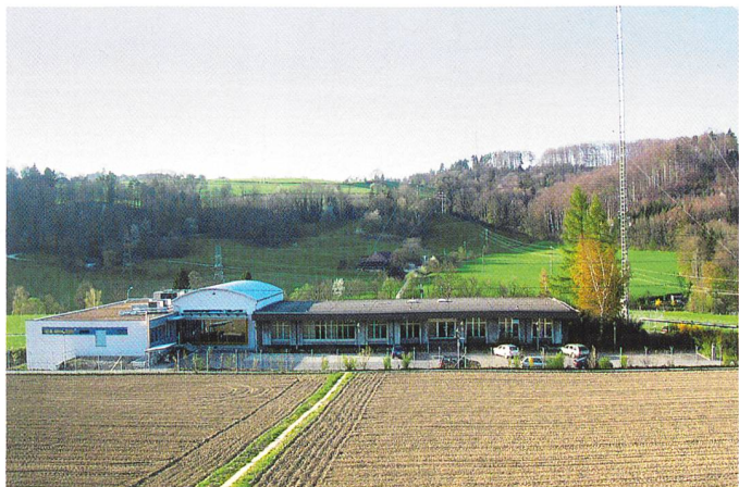
Die zentrale Leitstelle (ZLS) in Mühleberg mit dem Neubau (links).
