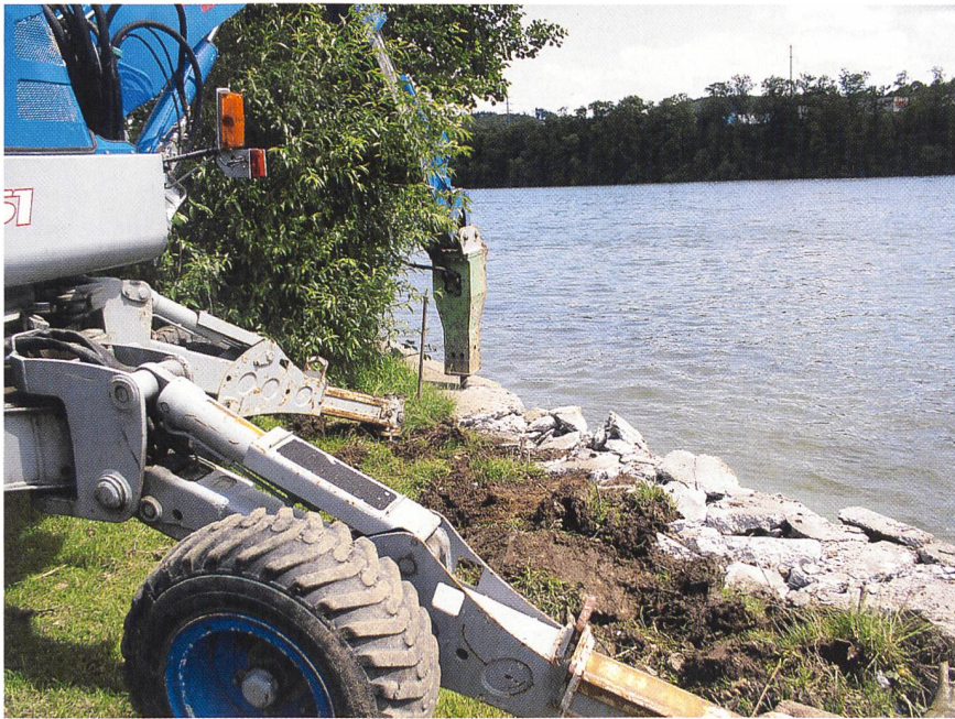
Uferverbauungen werden entfernt (Bilder: energiedienst).
