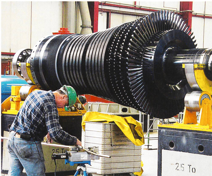
Jedes Jahr werden im Sommer die Kernkraftwerke für die Prüfung wichtiger Komponenten und Systeme sowie zum Ersatz von Brennelementen abgestellt. Oben: Eine der beiden Hochdruckturbinen von Block 1 des KKB wurde revidiert. Beide Kernkraftwerke Beznau I und II sind wieder in Betrieb (Bild: nok).
