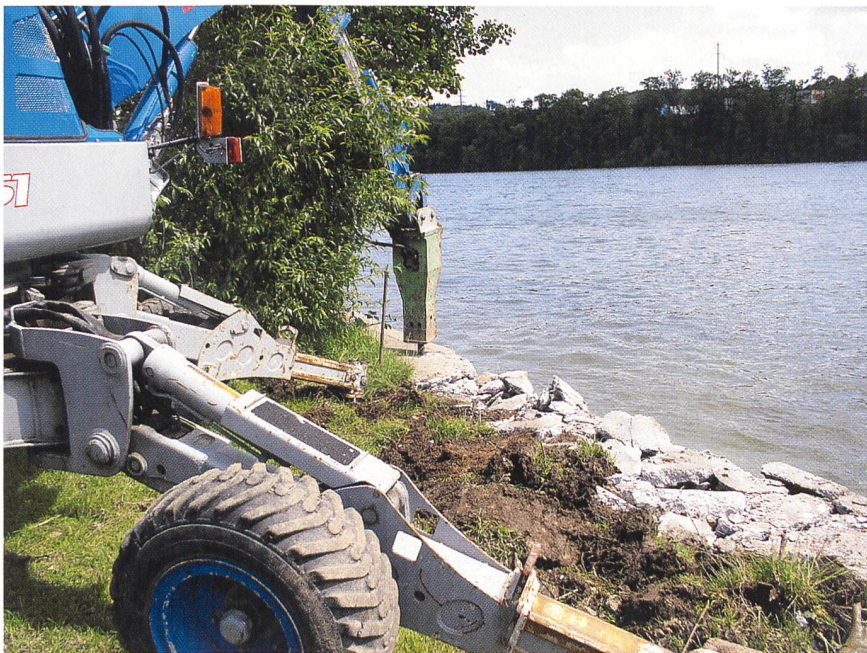
Uferverbauungen werden entfernt (Bilder: energiedienst).
