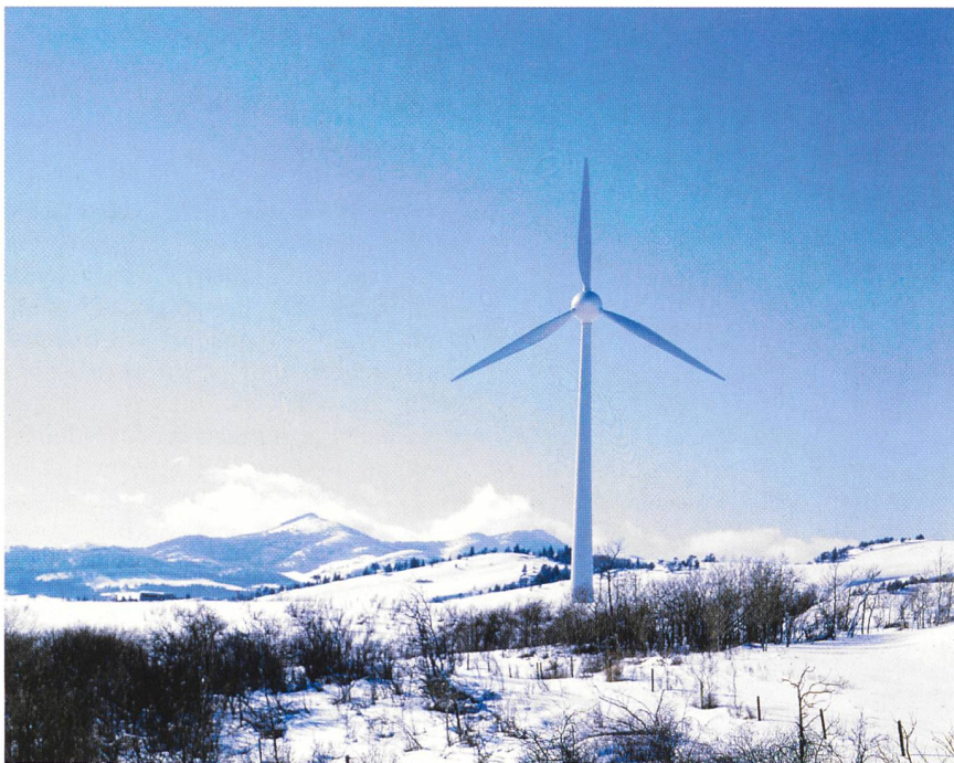
Beim neuen Anlagentyp handelt es sich um eine vielfach erprobte Installation – auch in arktischem Klima: eine E-40 in Kanada (Bild: Enercon).
