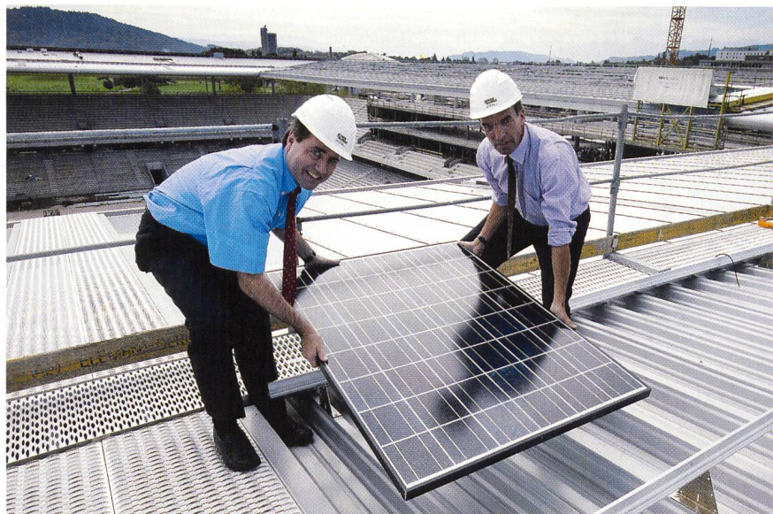
Dr. Jakob Vollenweider, Leiter BKW-Energiekommunikation (links), und Dr. Martin Pfisterer, BKW-Konzernleitungsmitglied, setzen auf den Dachflächen des Stade de Suisse Wankdorf Bern das erste Sonnenpanel für das weltgrösste stadionintegrierte Sonnenkraftwerk (Bild: Philipp Zinniker).
